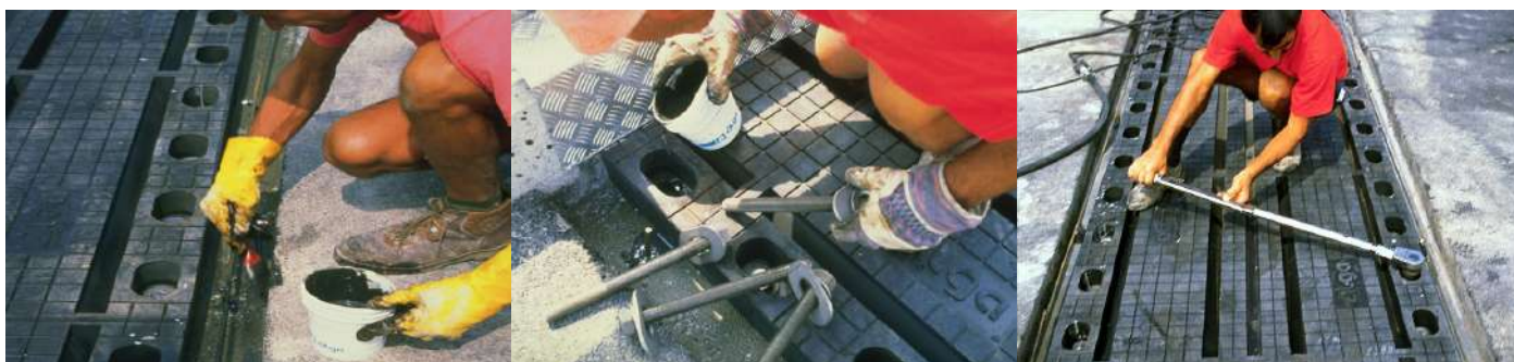
Fasi di installazione. Installation phases.
